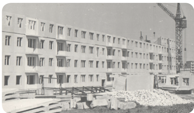
Строительство 119-квартирного дома преподавателей
